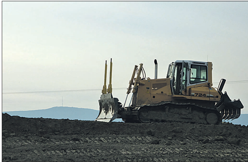
Deponiesanierung in Haßloch: Hier wird Oberboden-Material eingebaut.
