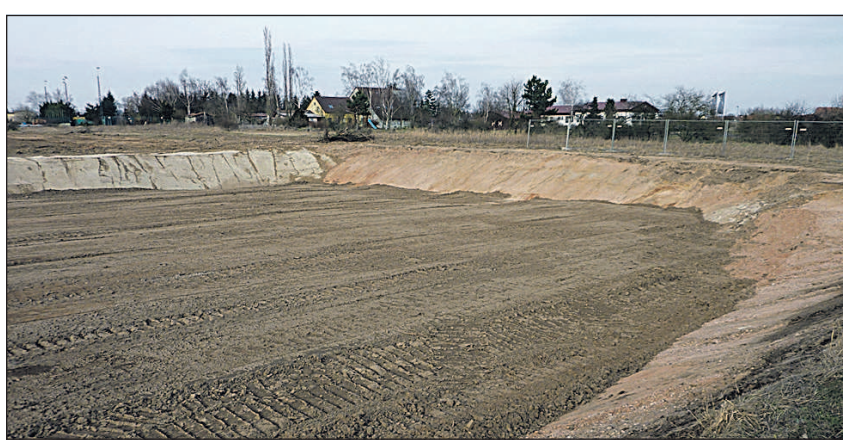
Fortschritt: Im südöstlichen Deponiebereich ist eine Versickerungsmulde entstanden.
