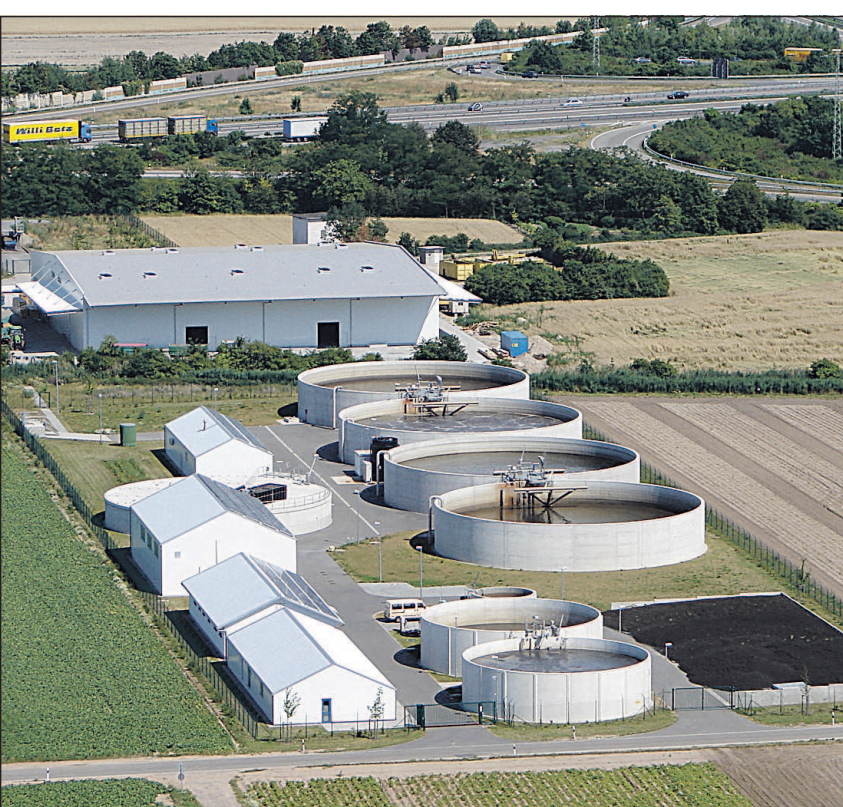
Überblick: Die Gruppenkläranlage des Zweckverbands „Mittleres Eckbachtal“ von oben.
