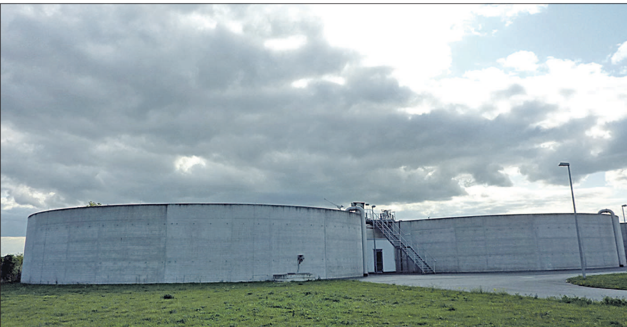
Volle Reinigungskraft: die Reaktoren für die biologisch-chemische Abwasserreinigung.
