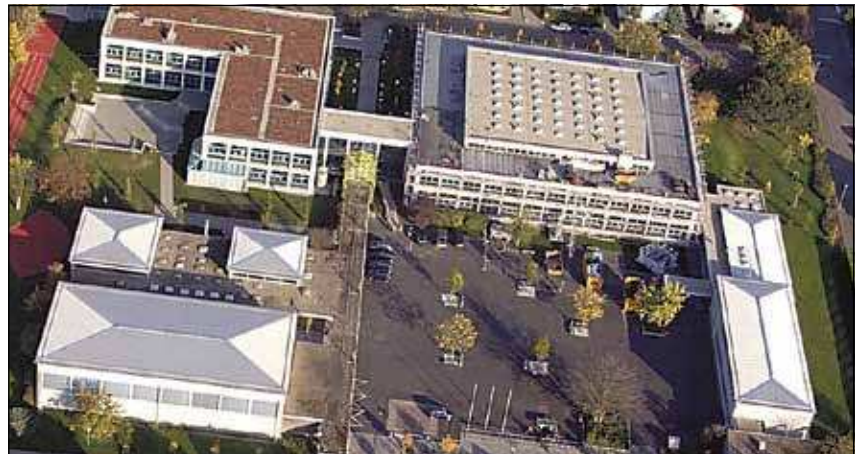
Blick aus der Luft von Westen auf das Hannah-Arendt-Gymnasium in Haßloch. Unten verläuft die Viroflayer Straße. Die Turnhalle (l.) und die Nebengebäude (dahinter) werden abgerissen und erneuert.
