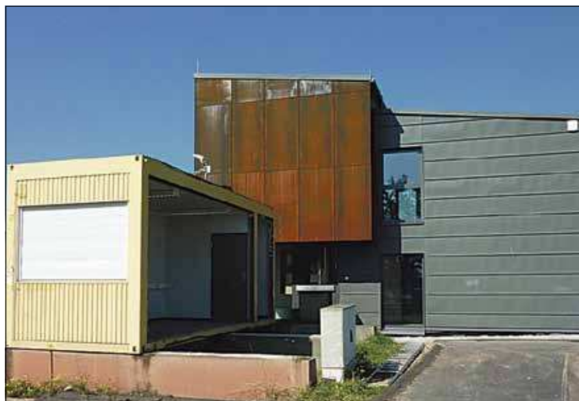
Provisorisch: Die Büro- und Sanitärcontainer waren über zehn Jahre der Arbeitsplatz der Mitarbeiter des Abfallwirtschaftsbetriebs. Er stand am Eingang zur Deponie Friedelsheim.
