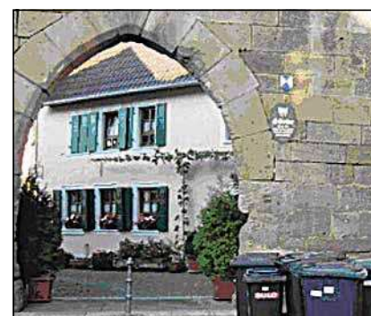
Engstelle: Freinsheimer Stadtmauertor.
