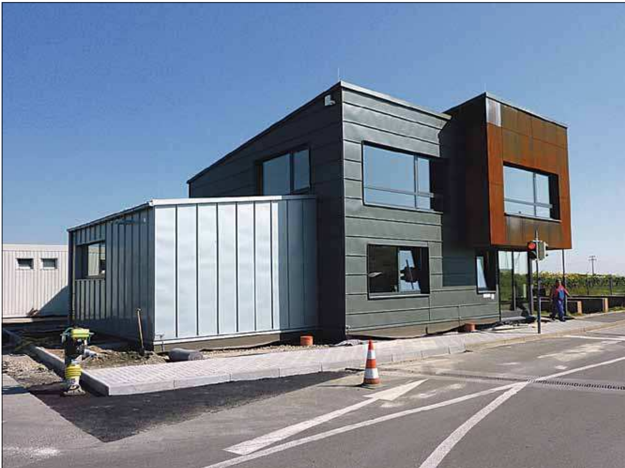
Bezugsfertig: Im Sommer 2009 begannen die Bauarbeiten, jetzt wurde das neue Betriebsgebäude auf dem Wertstoffhof Friedelsheim eingeweiht. Es gibt Werkstatt- und Personalräume sowie einen Vortragsraum – und endlich auch Trinkwasser.
