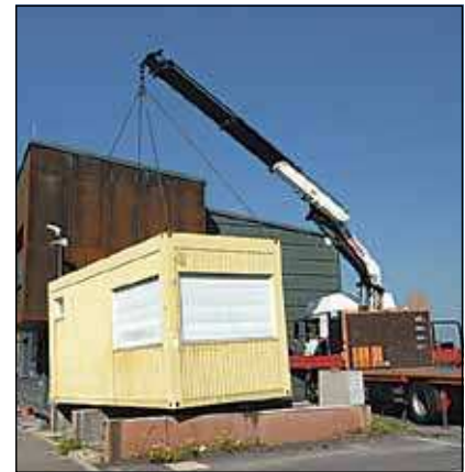
Abtransport: Mit einem großen Kran wurde der provisorische Container weggeschafft.
