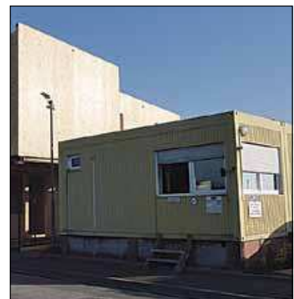
Aufgestellt: Der Rohbau zeigt schon, wie das feste Betriebsgebäude aussehen wird.
