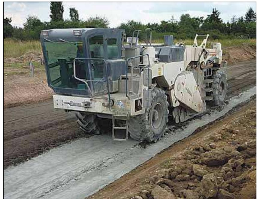
Fräsmaschine im Einsatz: Der Zement wird zur Deponieabdichtung eingebracht. Die richtige Menge wurde vorher an einem sogenannten „Probekörper“ getestet.
