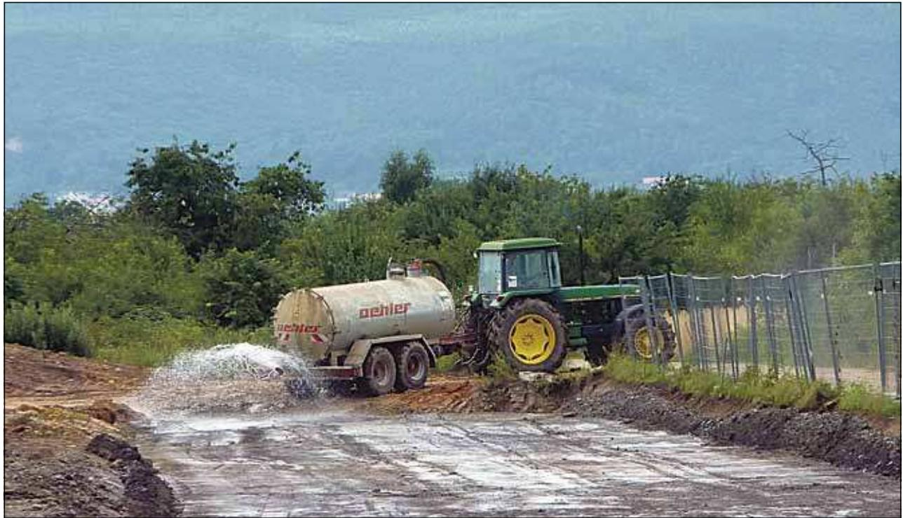
Wasser für die Zementmischung: Die richtige Zusammensetzung ist wichtig für die Oberflächenabdichtung der Deponie.
