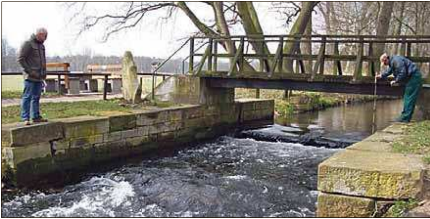
Vorher: Die Sohlschwelle behindert Fischarten, die wie Lachse bachaufwärts wandern.
