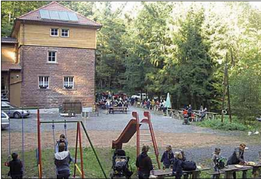
In 80 Jahren zum beliebten Wanderstützpunkt und Ausflugsziel gemauert: das Oppauer Haus.
