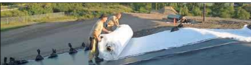
Die Oberfläche der ehemaligen Deponie Ellerstadt wird im Zuge der Sanierung abgedichtet.
