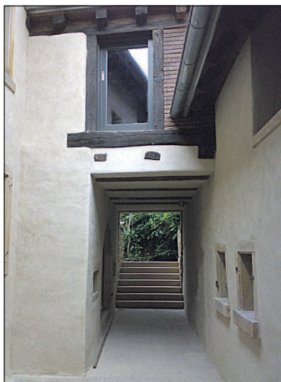
... der Sichtbeton am neuen Durchbruch und ...
