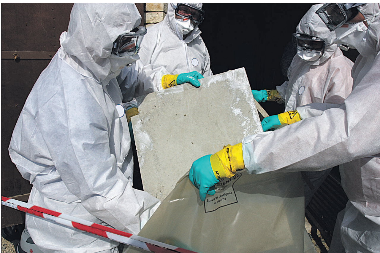
Auf Nummer sicher: Asbestzementplatten müssen in reißfesten Kunststoffsäcken zur Deponie gebracht werden.
