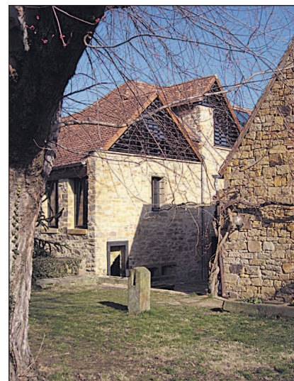
... die Lamellenstruktur der einstigen Scheune.
