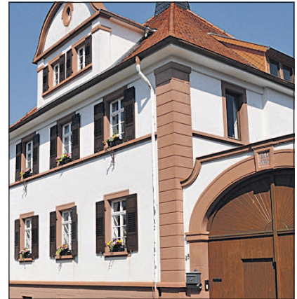
Noch keine 100 Jahre alt und schon Denkmal: Wohnhaus eines Winzerhofs in Gerolsheim aus dem Jahr 1925 – im sogenannten Heimatstil nach barocken Vorbildern gebaut.
