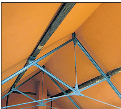
Maßgefertigt: Das Sprengwerk im Wohnzimmer.
