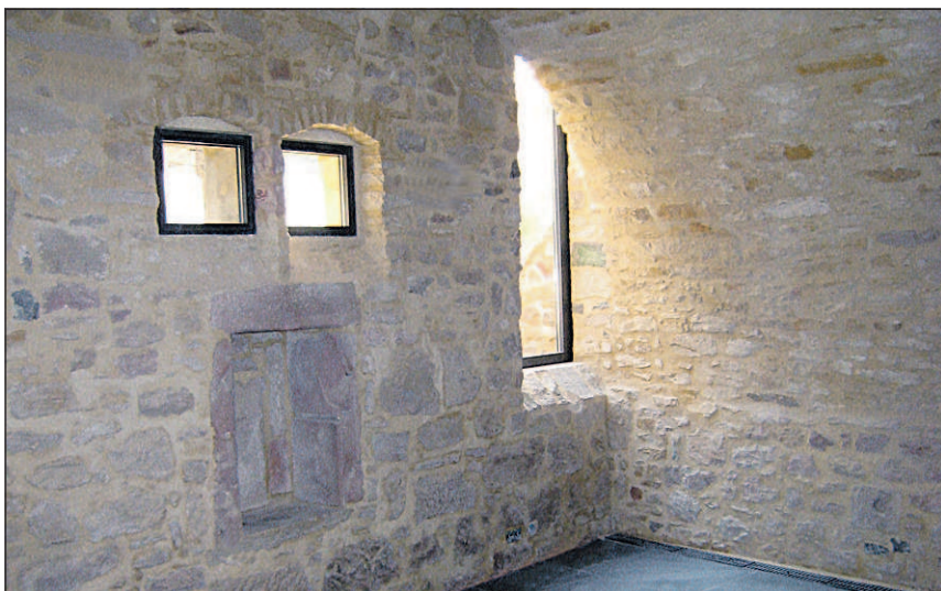
Liebevolle Details machen die Sanierung zur Meisterleistung: das Galeriefenster im Gewölbekeller ...
