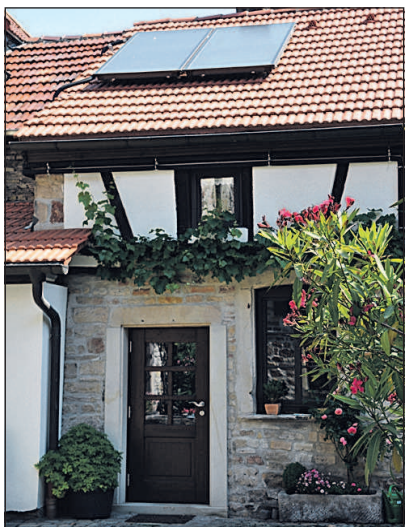
Gelungenes Zusammenspiel von Denkmalpflege und Solarenergie: Haus in Wattenheim.
