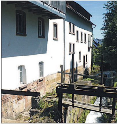
Obermühle bei Haßloch: Aus einem verlassenen Mühlenkomplex aus dem 18. und frühen 19. Jahrhundert entstand eine moderne Begegnungsstätte mit Praxen und Wohnungen.
