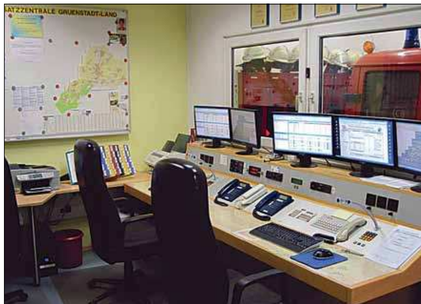
Feuerwehreinsatzzentrale VG Grünstadt Land – die moderne Digitale Alarmierungseinrichtung mittels Computern.
