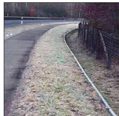
Teure Schutzmaßnahme: Fest eingebaute Amphibienleiteinrichtung an der B 47.
