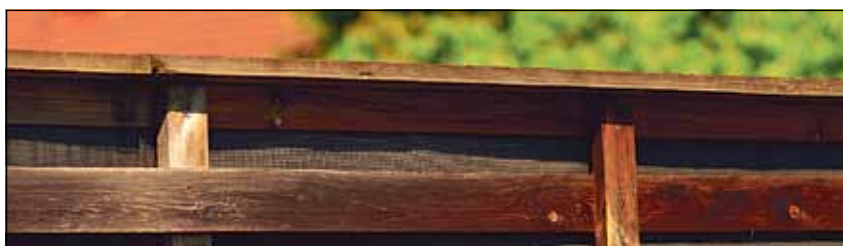
Ob jahrelang im Einsatz oder frisch errichtet: Sobald Gartenzäune und Gartenmöbel aus imprägniertem Holz entsorgt werden sollen, gelten sie als gefährlicher Abfall.
