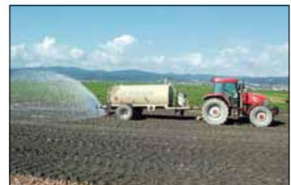
Fräsfeld: Aufbringen des Schlacke-Ton-Gemischs, mit einer Hochleistungsfräse mischen und immer wieder Wasser zugeben.
