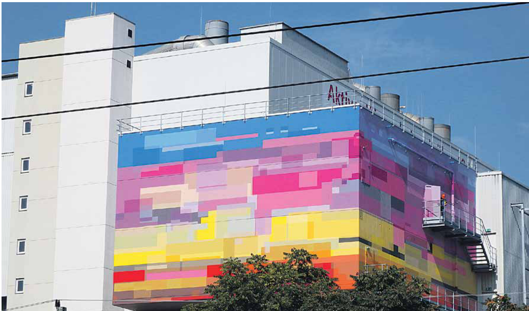
Setzt einen städtebaulichen Akzent: die Fassadengestaltung des neuen Müllbunkers. Fotos (3): GML
