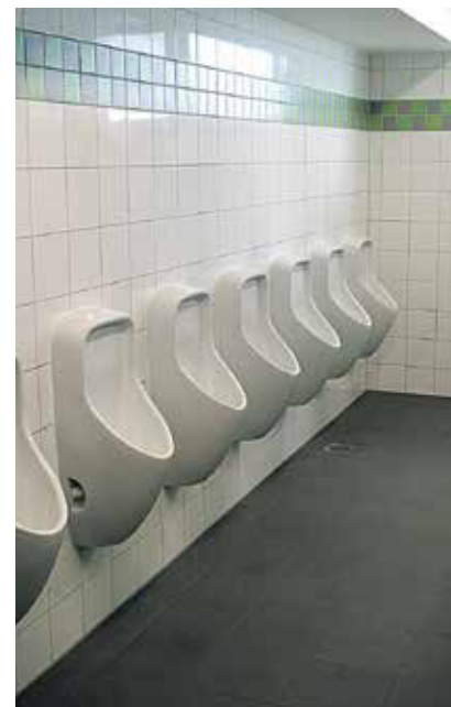
Komplett renoviert: Toilettenanlage in der Lambrecht-Schule.
