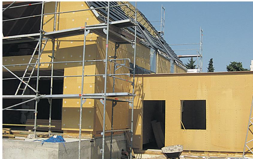
Dick eingepackt: Gedämmt wurde mit Holzfaserplatten. Foto: Eckert
