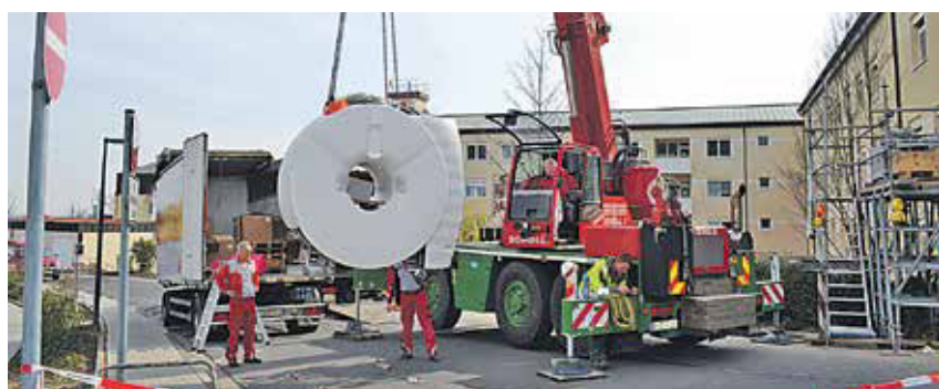
Anlieferung des knapp sechs Tonnen schweren MRT im Kreiskrankenhaus Grünstadt. Fotos: Krankenhaus/Anja Benndorf
