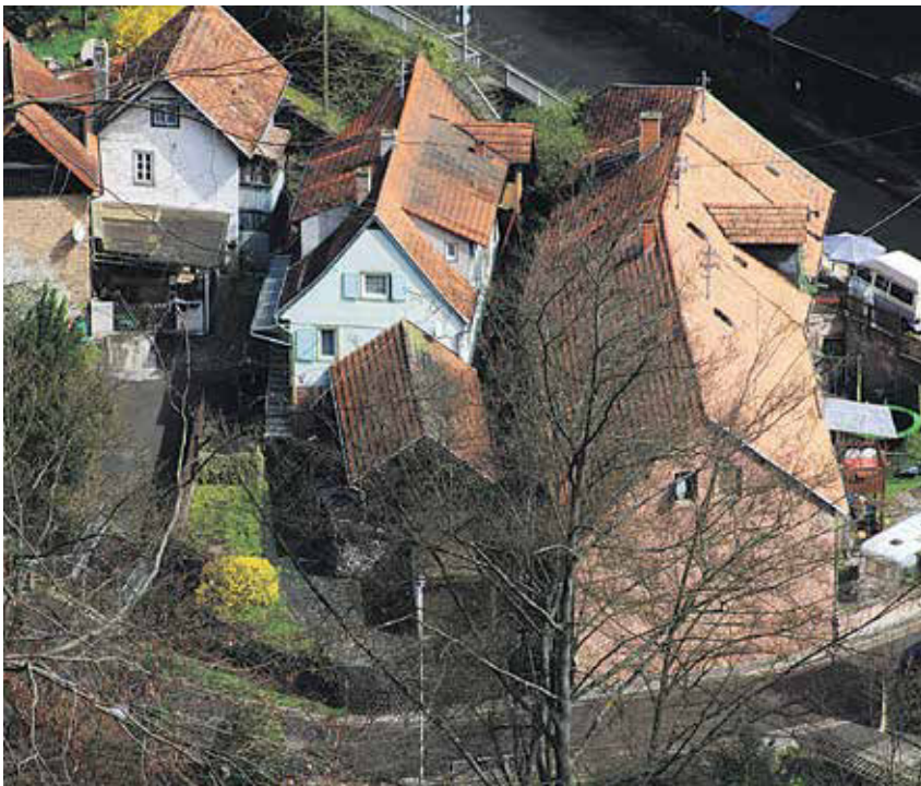
Technisch bedeutendes Kleinod: das Mühlenensemble mit Wappenschmiede in Elmstein unterhalb der Burgruine. Fotos (5): Benno Münch
