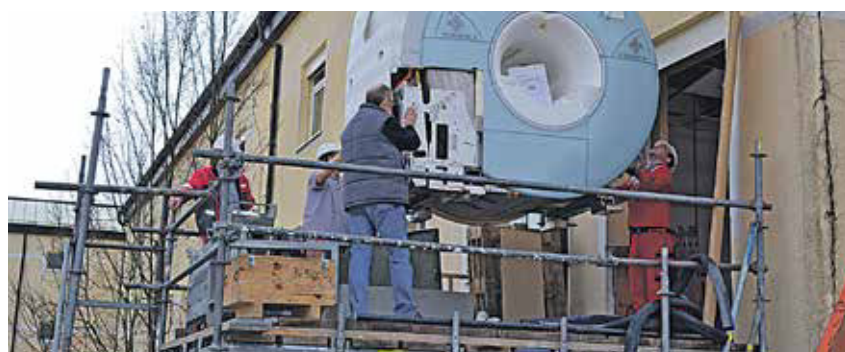
Nach Absetzen auf dem Schwerlastgerüst wurde der MRT durch eine Öffnung in der Außenwand an seinen Bestimmungsort gebracht.
