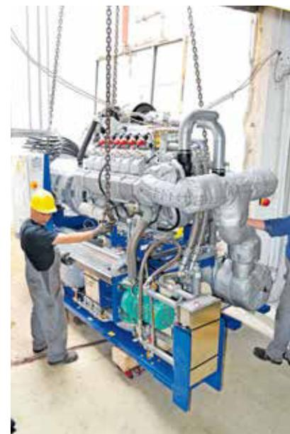
Mit einem Autokran wurde das Aggregat durch den Versorgungsschacht in die Energieversorgungszentrale im Untergeschoss des Krankenhauses gehoben. Fotos (4): Kreiskrankenhaus Grünstadt
