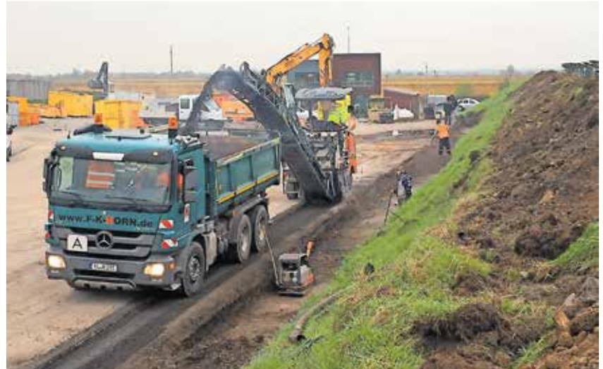
Stand der Bauarbeiten Anfang November: Abfräsen der alten Asphaltsschicht und ausgehobener Graben für die Frostschutzschicht der neuen Stahlwände.
