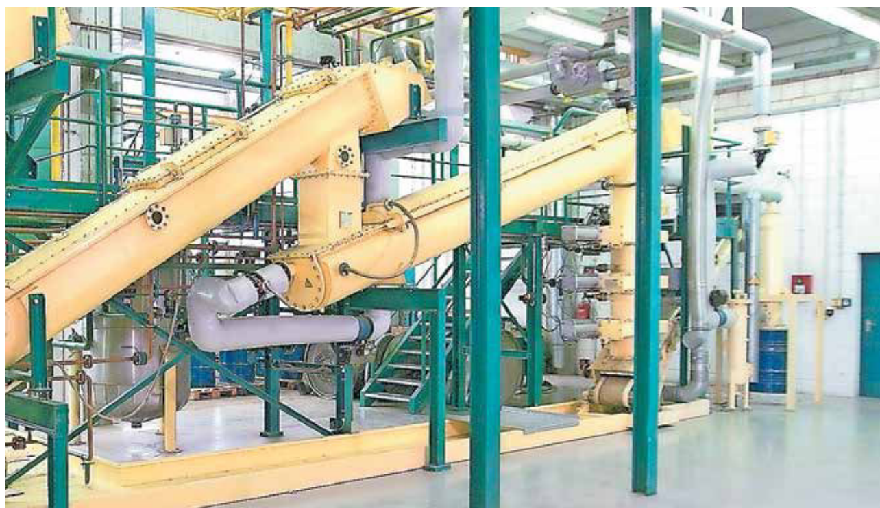
Das Laufband 1-K-Anlage im bayrischen Werk: Über das Förderband gelangen die 1-K-PUR-Schaumdosen in die Recyclinganlage, wo sie unter Luftabschluss geknackt und mechanisch zerkleinert werden. Foto: PDR
