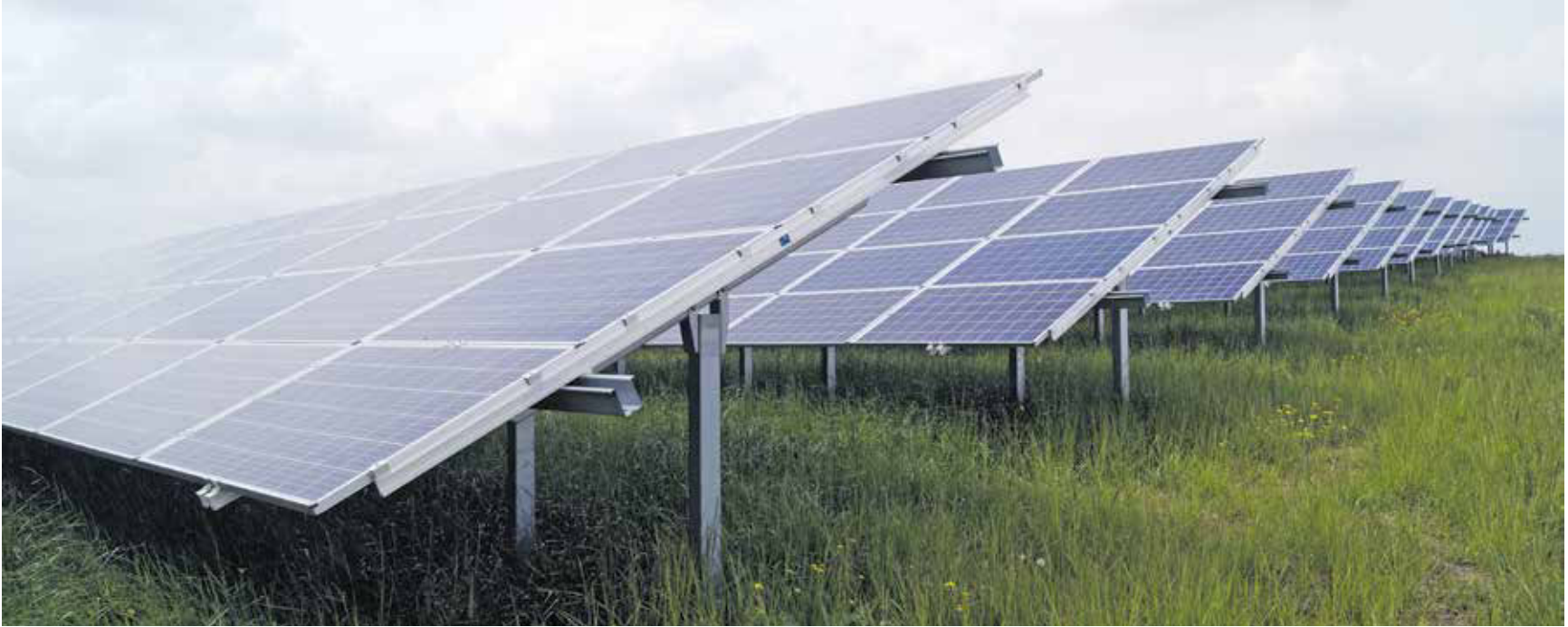
Sonnenkollektoren sorgen für sauberen Strom: der Energiepark in Ellerstadt.
