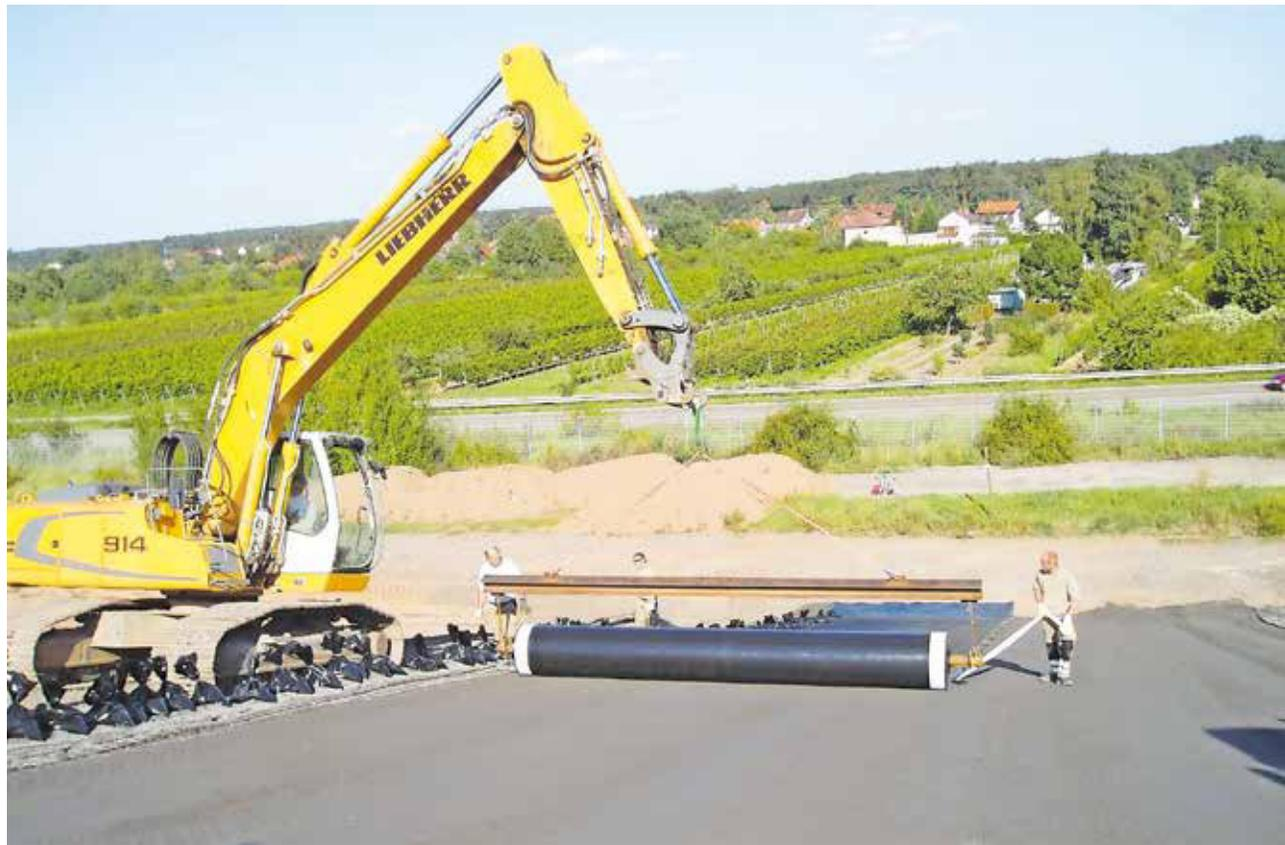
Präzisionsarbeit: Um Gasaustritt zu verhindern, müssen verschiedene Schichten aufgetragen werden. Fotos: AWB
