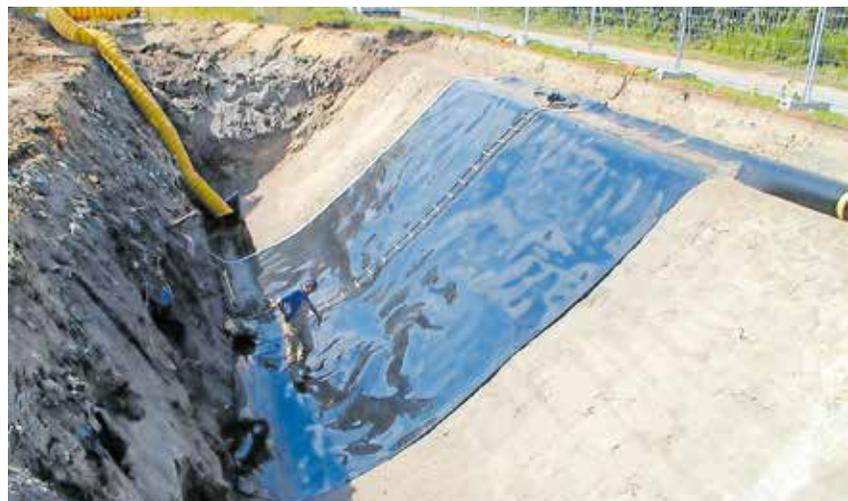
Die verwendeten Kunststoffdichtungsbahnen müssen so ausgelegt sein, dass sie für mindestens 100 Jahre halten.
