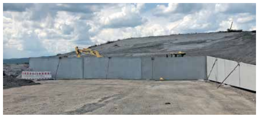
Vor dem neu profilierten Deponiekörper: die Betonstützwand, die gerade im Bau befindlich ist. Foto: AWB/König
