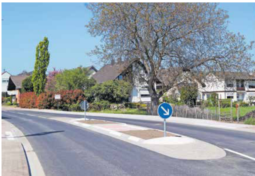
Kreiseigenes Bauen: Die Kreisstraße K10 in Ruppertsberg wurde zum Beispiel 2015 vom Landkreis erneuert. Foto: KV/Müller
