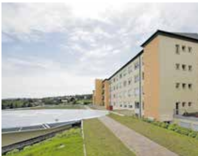
Seit 1973 vorhanden: Hubschrauberlandeplatz. Fotos: Kreiskrankenhaus
