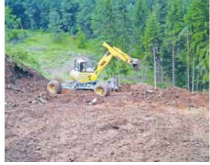
Schreitbagger im Einsatz: Sanierung der Deponie Esthal 2007.
