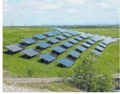
Zusatznutzen der Deponie Friedelsheim: Photovoltaikanlage.
