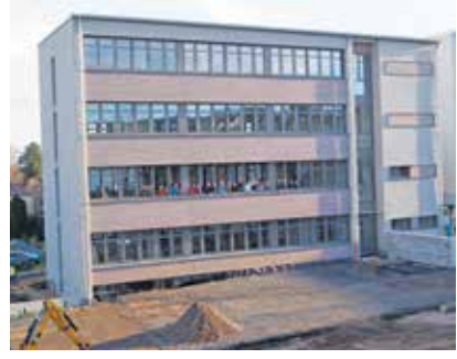
Seit 2019 neues Domizil des AWB: Bau in der Prof.-Otto-Dill-Straße.
