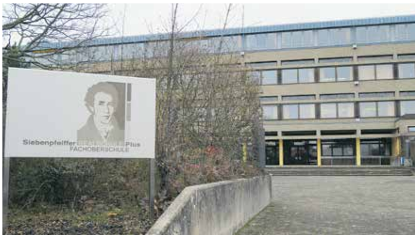
Soll energetisch saniert werden: Siebenpfeiffer-Realschule Haßloch. Foto: KV/Müller
