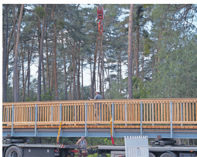
Fertig angeliefert: Die Brücke kommt auf einem Lkw und wird montiert.
