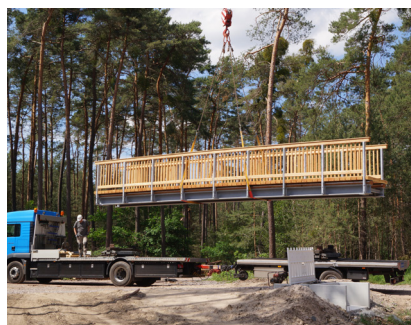
Luftnummer: Kurz schwebt die acht Tonnen schwere Brücke ...
