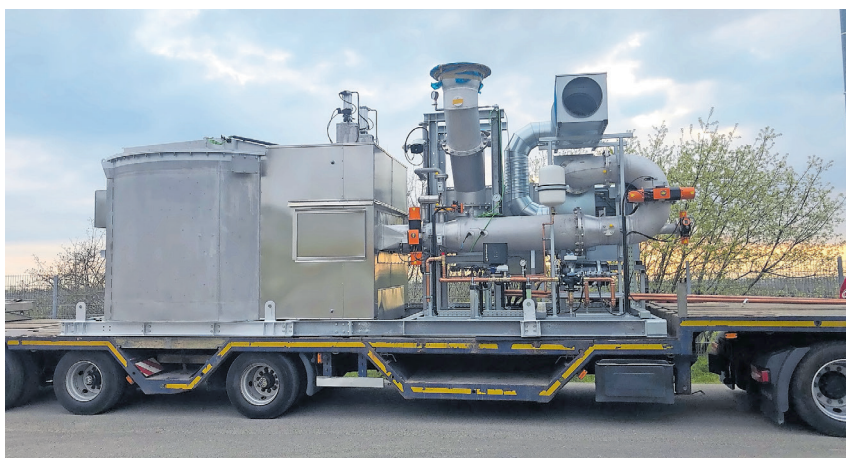
Ausladend: Transport der Anlage auf dem Hänger zur Deponie.
