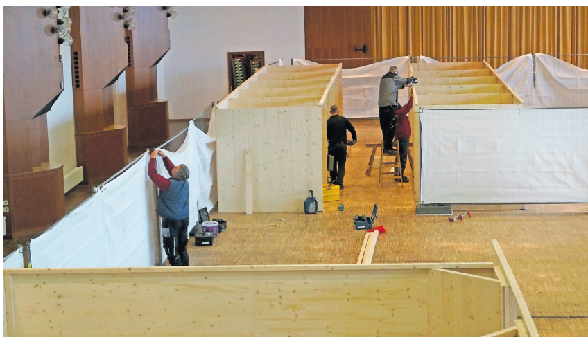
War doch recht aufwendig: der Umbau der Bad Dürkheimer Salierhalle zum Impfzentrum. Foto: KV/Müller
