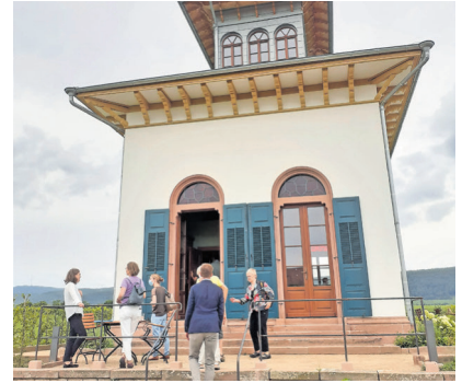
Historisches Gemäuer, komplett saniert: das Teehaus.
