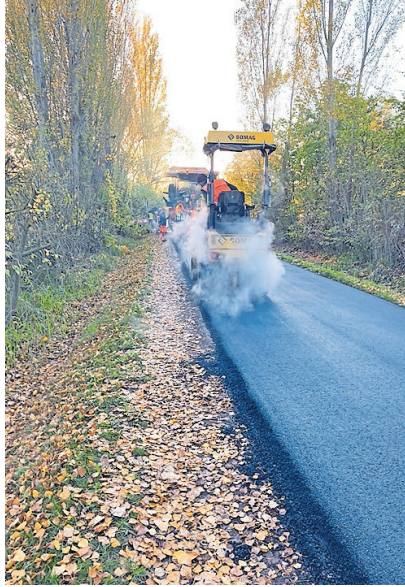
Inzwischen abgeschlossen: Bauarbeiten bei Bad Dürkheim. Foto: Stadt DÜW
