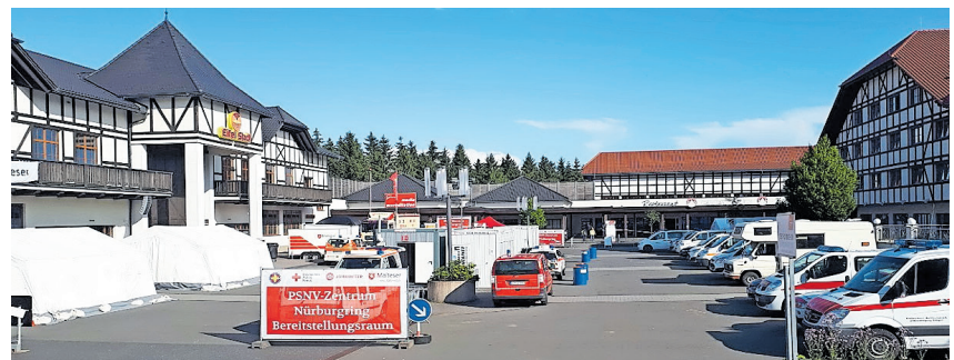
Das PSNV-Zentrum am Nürburgring. Foto: FERD
