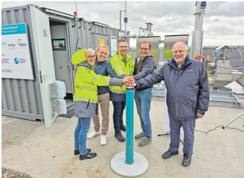
Bei der Einweihung der RTO-Anlage in Ellerstadt (von links): Deponieleiterin Susann Kohn, Joachim Lechner, Geschäftsführer der Contec-Ingenieurgesellschaft für Energie und Umweltechnik, Roland Haubrichs von der Lambda-Gesellschaft für Klimaschutz und regenerative Energien, AWB-Projektleiter Bernd Lache sowie Landrat Hans-Ulrich Ihlenfeld. Fotos: KV/Estelmann
