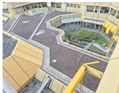
Oberste Schicht: das wasserspeichernde Granulat.
