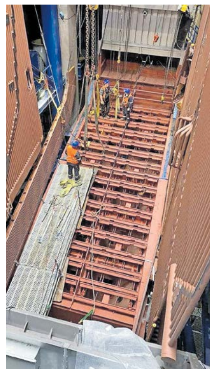
Im laufenden Betrieb wurde der Rost montiert.
