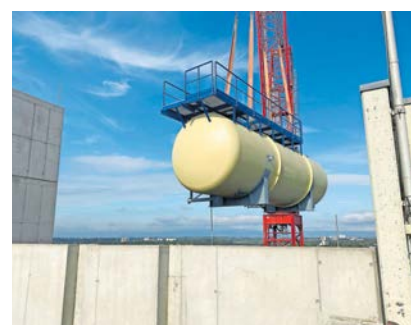
Der Schwerlastkran beim Einheben des Speisewasserbehälters.
