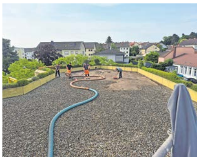
In einem ersten Arbeitsschritt wurde das alte Granulat abgesaugt.
