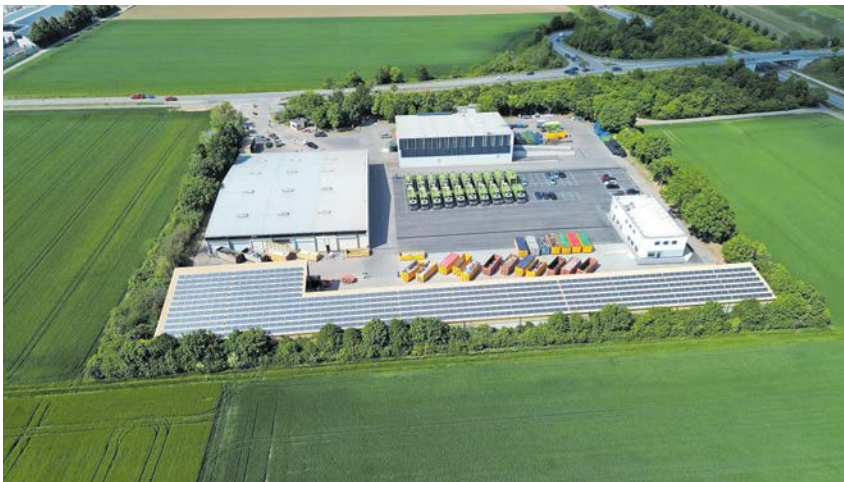
Das Abfallwirtschaftszentrum aus der Vogelperspektive. Foto: KV
